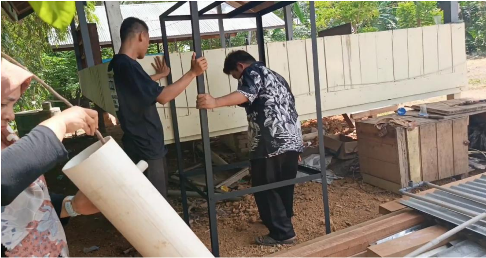
Gambar :Masyarakat membantu pemasangan alat pengolahan air
