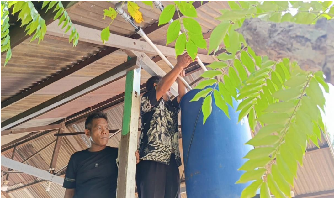
Gambar : Pemasangan pipa venturi aerator
